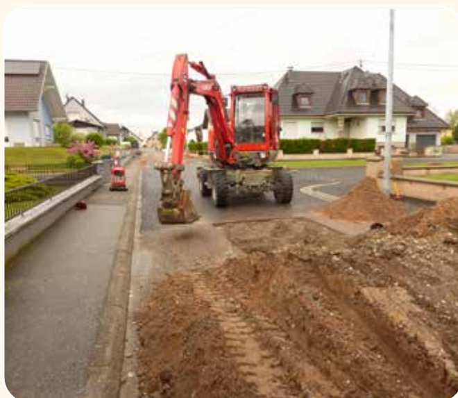
Rue de la Gare : Remplacement d'un tampon d'un regard d'assainissement affaissé et défectueux
