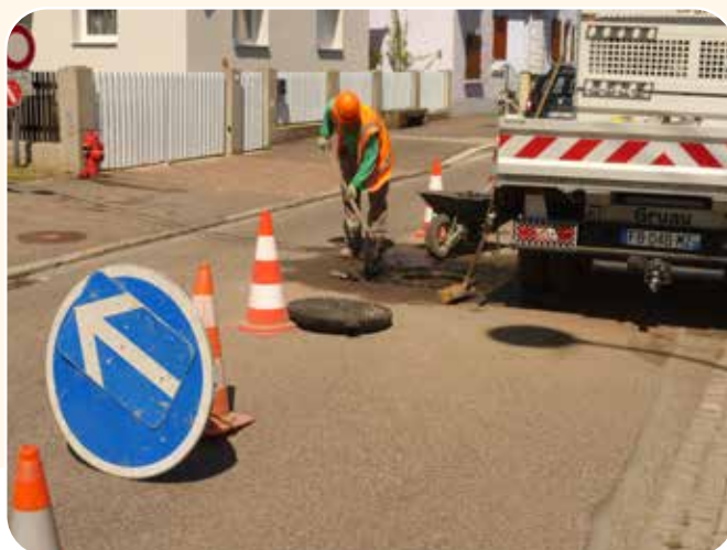
Rue de la Gare : Remplacement d'un tampon d'un regard d'assainissement affaissé et défectueux
