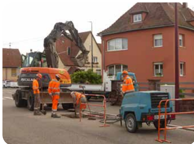
Rue des Sapins : Traitement d'étanchéité à chaud de fissures sur chaussée
