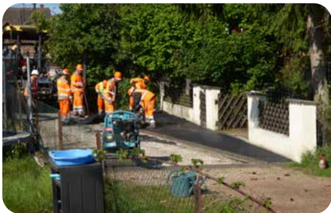
Place de la Liberté : Scellement d'une bordure
