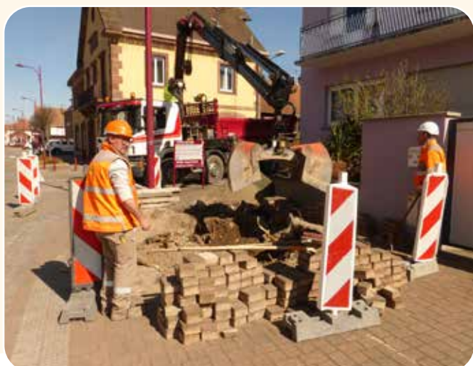
Intersection rue de la Liberté-rue du Lin : Remise à niveau du pavage et des bordures en granit d'un encadrement et plantation d'un nouvel arbre
