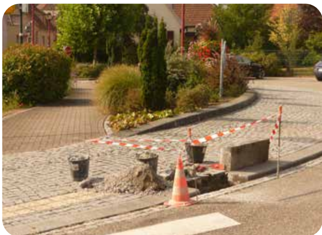
Rue des Mélèzes : Reprise d'un affaissement suite à une rupture d'une canalisation d'assainissement
