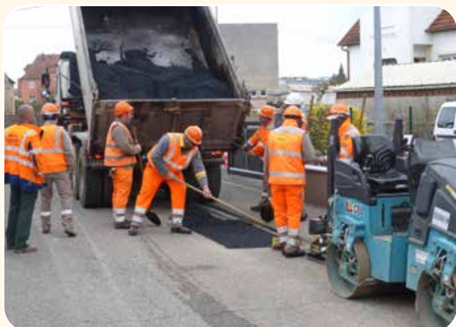
Rue du Stade : Rénovation partielle du trottoir et reprise d'affaissements sur chaussée
