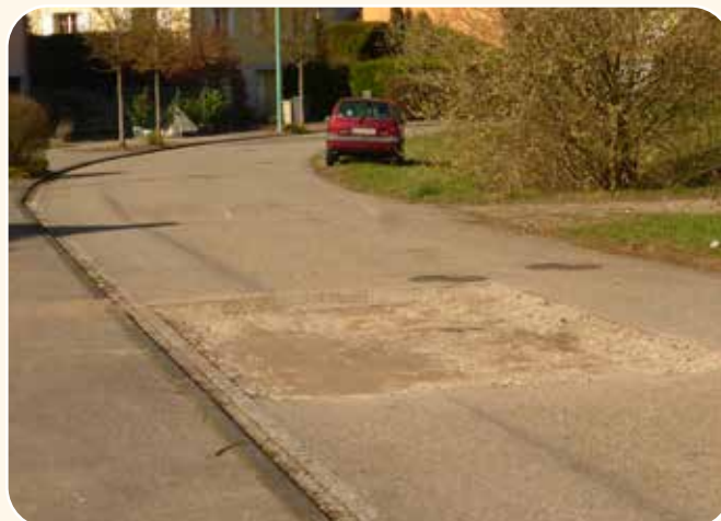
Rue de la Boissellerie : Réfection en enrobés du trottoir et jointage à l'émulsion de bitume
