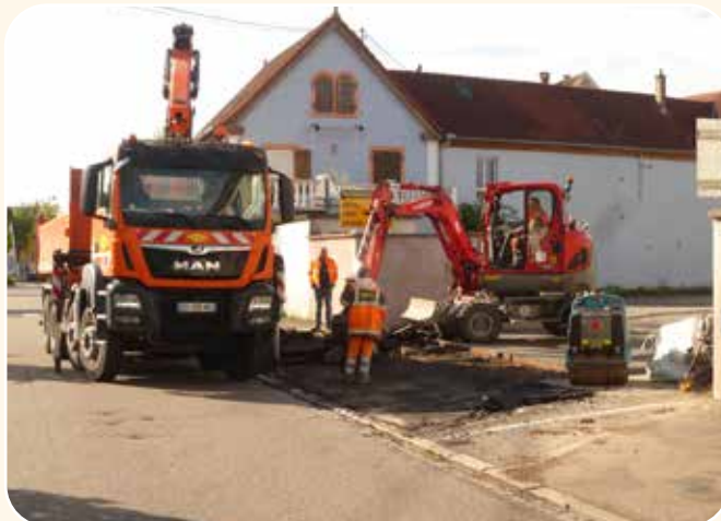
Rue des Roses : Réparation d'une conduite d'assainissement endommagée
