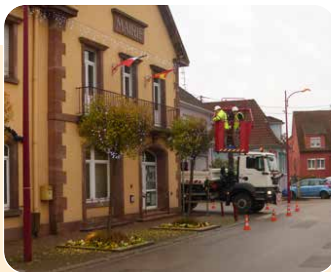
Installation de l'éclairage de Noël par les services techniques
