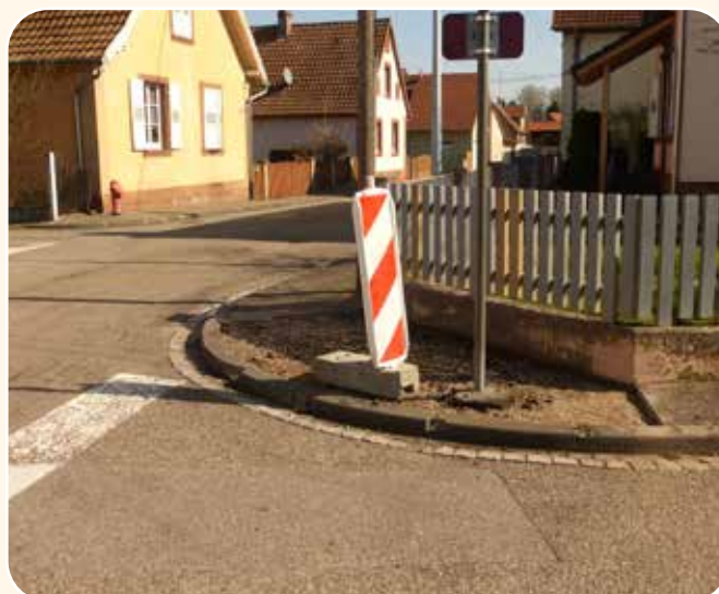
Rue du Jeu des Enfants : Reprise en enrobés de la chaussée suite à la formation d'un trou et d'affaissements
