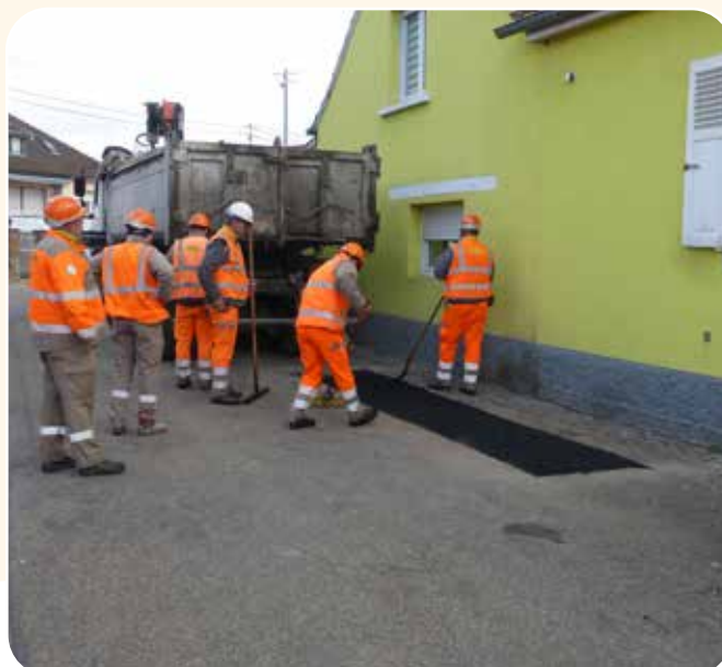
Rue du Jeu des Enfants : Reprise en enrobés de la chaussée suite à la formation d'un trou et d'affaissements
