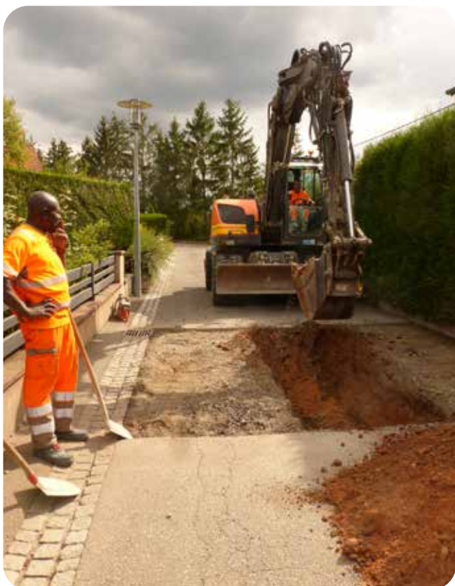
Rue des Mélèzes : Reprise d'un affaissement suite à une rupture d'une canalisation d'assainissement
