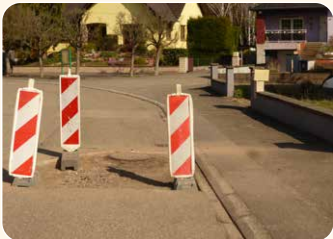
Rue du Wahl : Renouvellement d'un tapis d'enrobés sur trottoir
