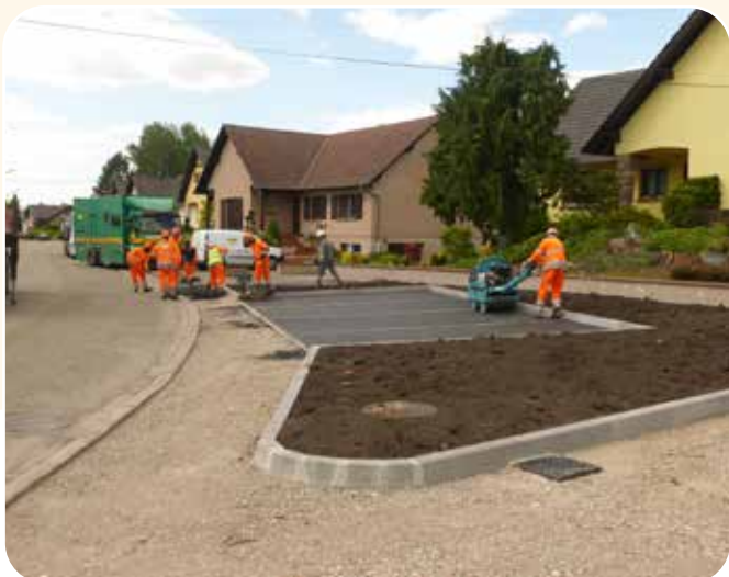
Rue des Primevères : Travaux d'aménagement d'une placette, de places de stationnement et suppression partielle de l'imperméabilisation du sol.
